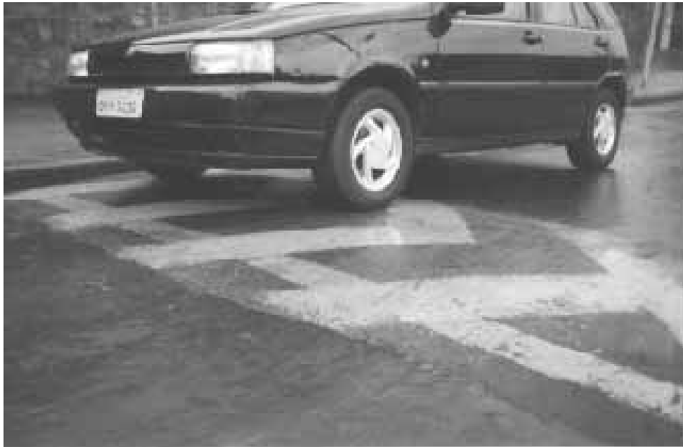
Figura 1. Fotografia mostrando uma lombada convencional encontrada nas vias públicas. A lombada é normalmente suave, procurando forçar a redução da velocidade dos veículos.
