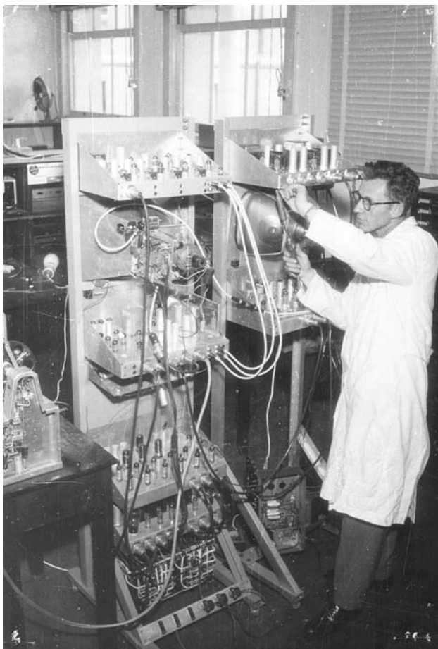
Figura 9 - Engelberto Werckmeister, instalando componentes no microscópio óptico com imagem projetada em cinescópio construído no CPF-URGS.
