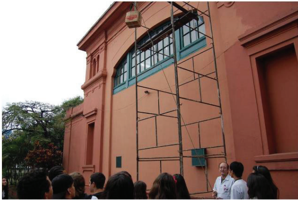
Figura 4 - Local dos testes. Em detalhe: andaimes de lançamento.
